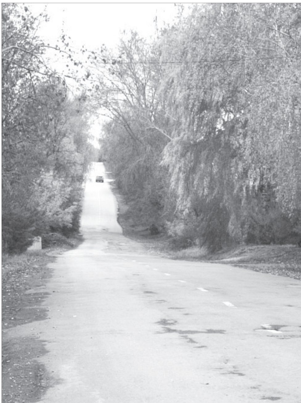
Дорога по улице Карла Маркса будет отремонтирована благодаря губернаторской поддержке
